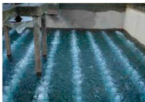
Үлээгч болон диффузор/сарниулах систем
